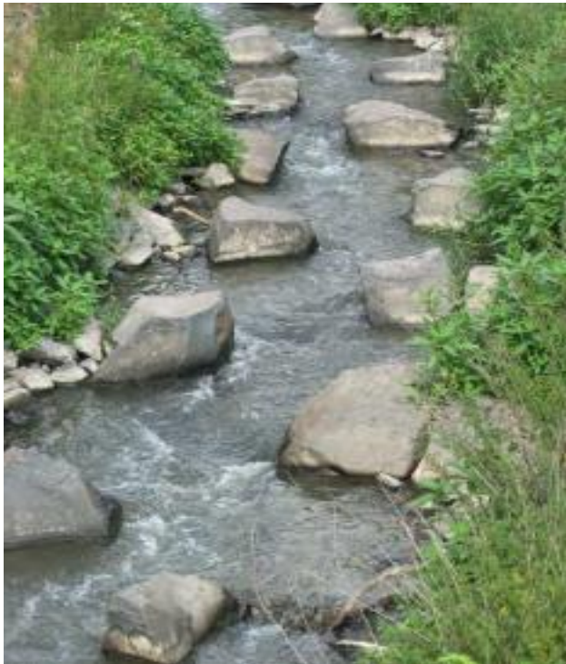
Abb. 5: Umgehungsgerinne in Form eines Raugerinnes mit Störsteinen am Elbbach bei Hadamar (Hessen) [1]
