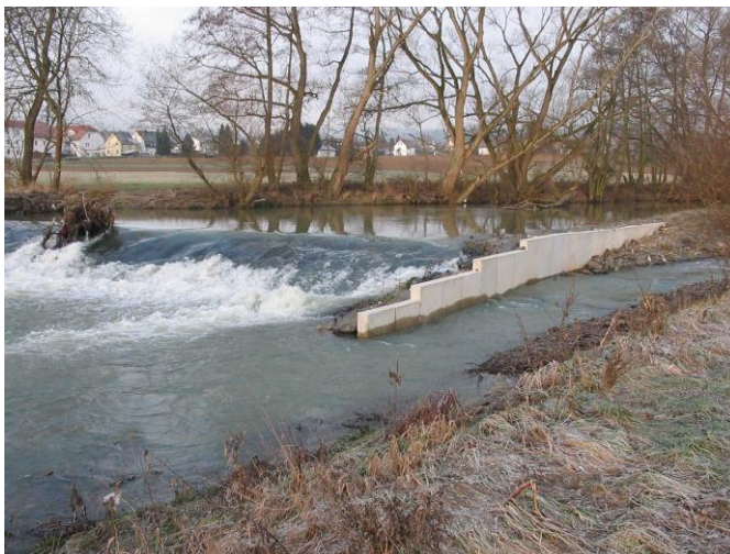
Abb. 4: Raugerinne mit Beckenstruktur und hydraulischer Trennwand [4]
