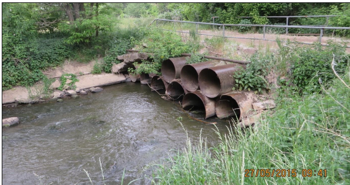
Abb. 3: Überfahrt mit Rohrdurchlässen bei Halle, Aufnahme datum: 27.05.2015
